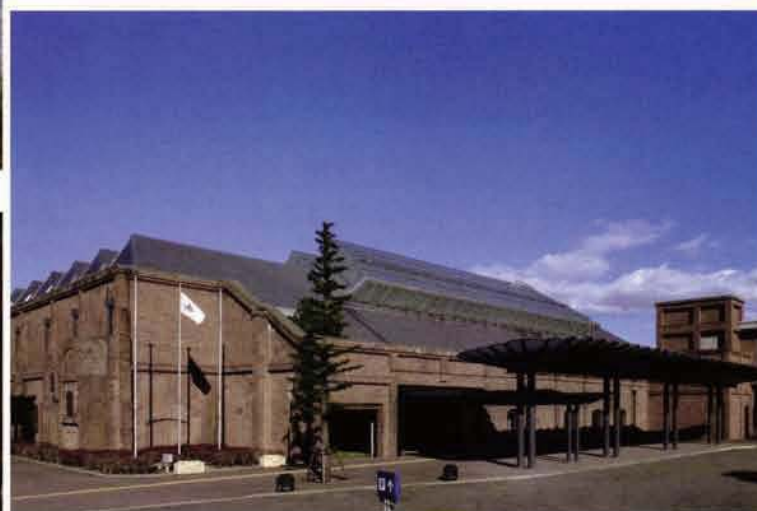
建物は赤レンガづくりの旧豊田紡織本社の工場を生かしている。
