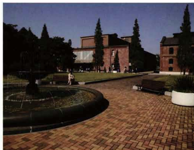
赤レンガ造りの建物は明治37年に建設された 日本陶器合名会社の最初の工場。昭和50年まで稼働していた。
